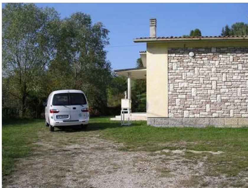
Foto 1 Campionatore rilocabile posizionato a Monfumo presso le ex-scuole elementari in località La Valle.
